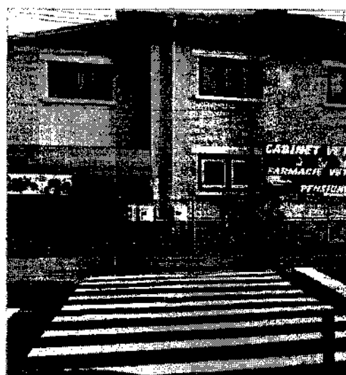
b) trotuar fără bordură îngropată în zona trecerii de pietoni
