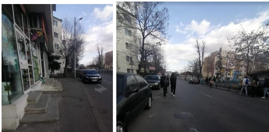
Figură 32 Lipsa trotuarului pe o porțiune de drum
