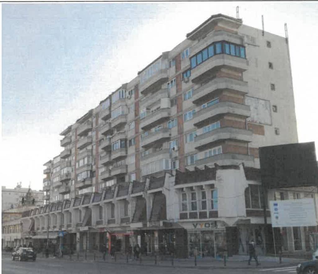
17. Bd. Carol, blocuri cu locuințe și parter comercial tipologia cu șarpantă învelitoare țiglă ceramică
