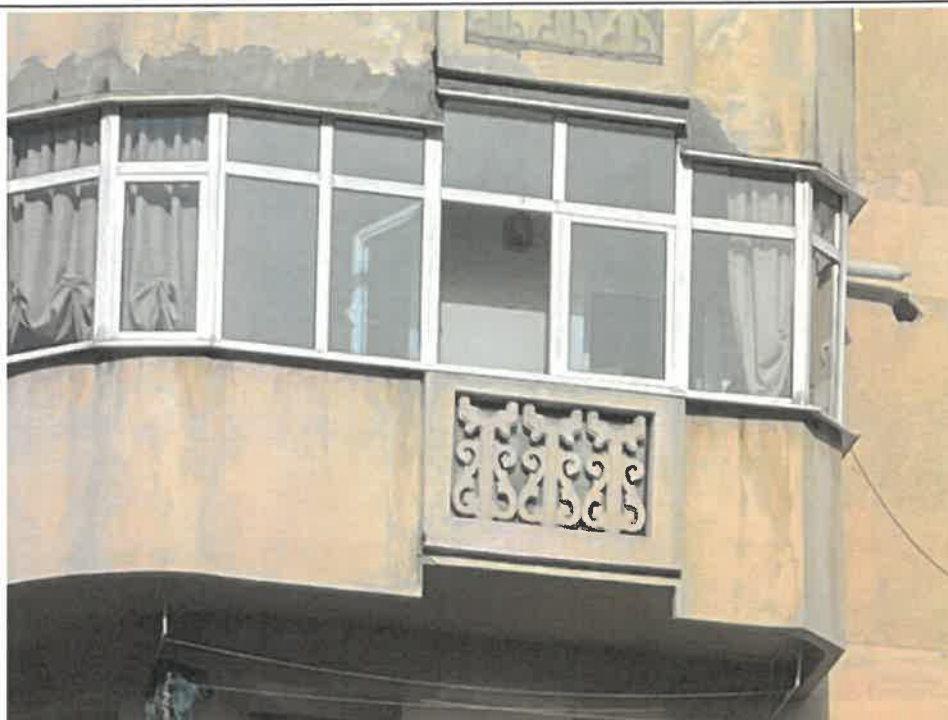
23. Detaliu balustrada blocuri din zona Parcului Trandafirilor
