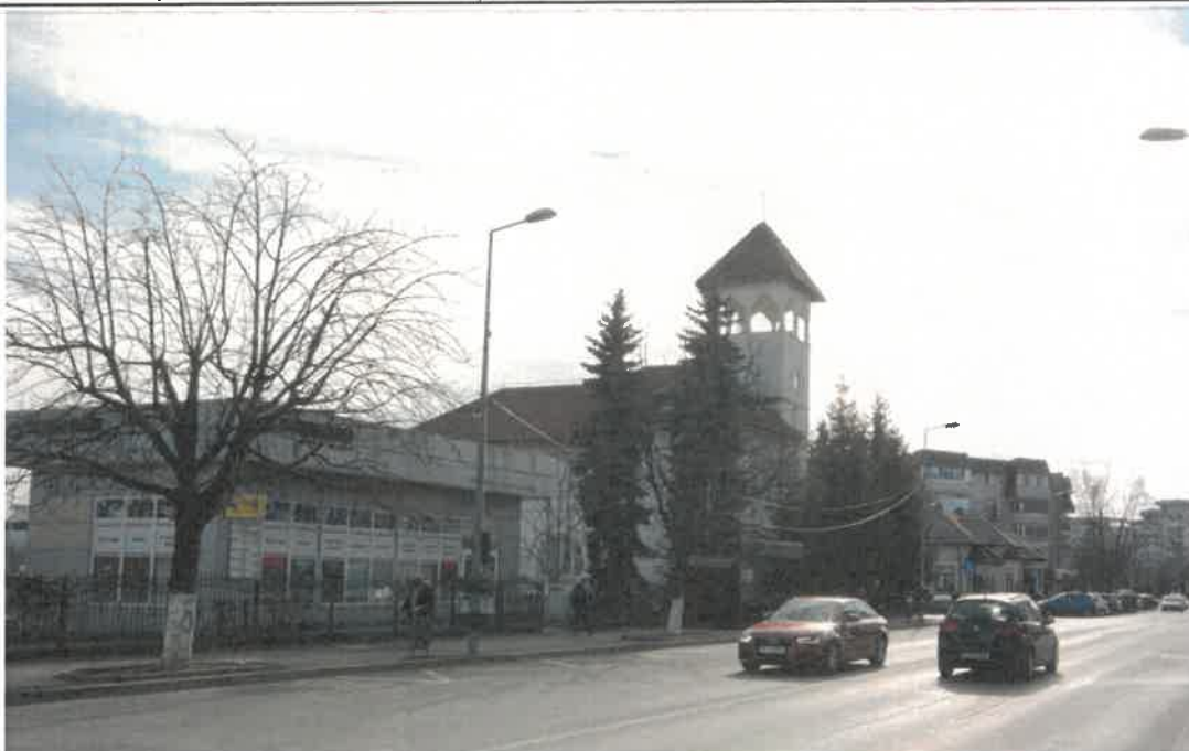
02. Bd. Carol vedere Vila D. Ștefănescu și corp clădire parter amplasat pe terenul vecin
