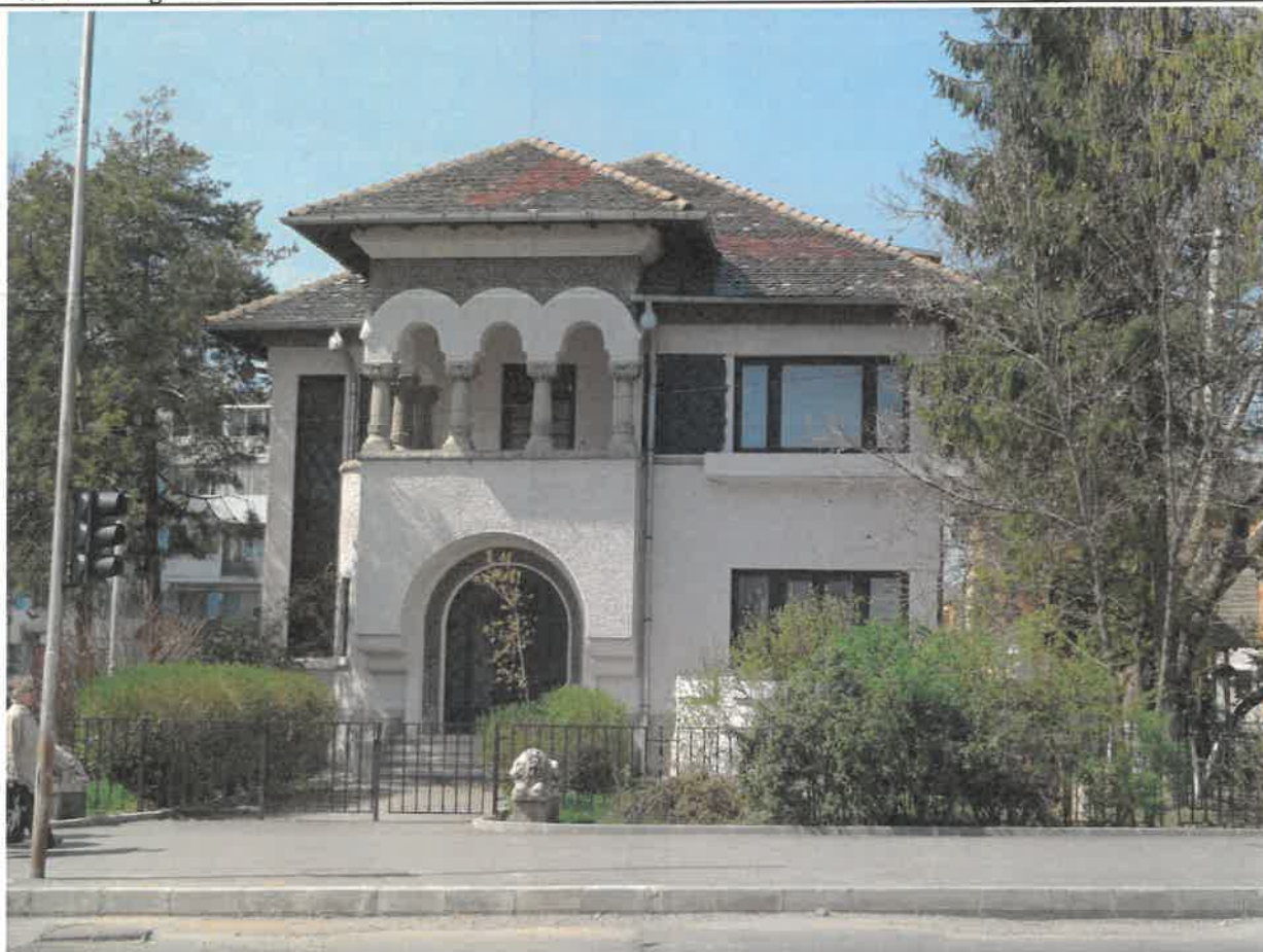
10. Vedere actuală a casei dr. Gherghi.
