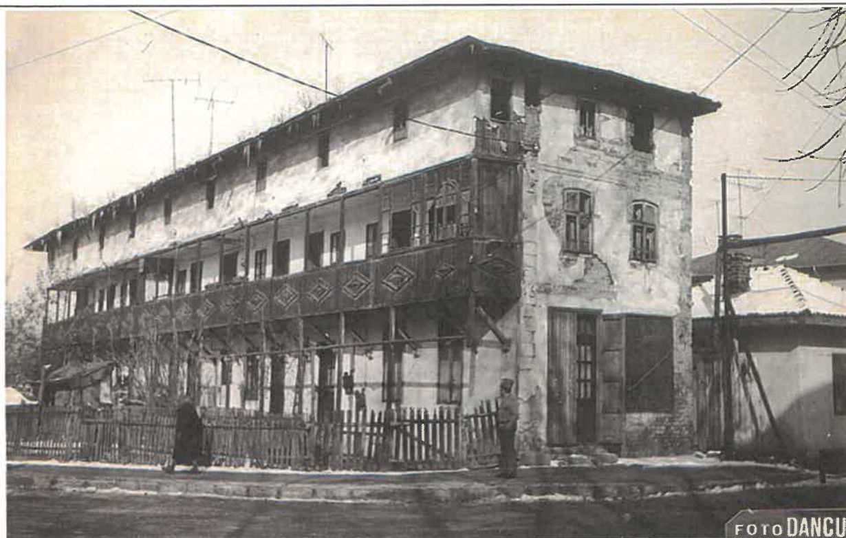
29. Hanul Pălămida demolat în anii 1990 se afla pe locul blocurilor din zona de nord a zonei de studiu
