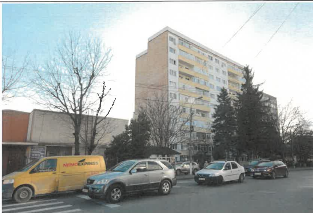
13. Blocurile P, vedere din intersecția str. Schelelor
