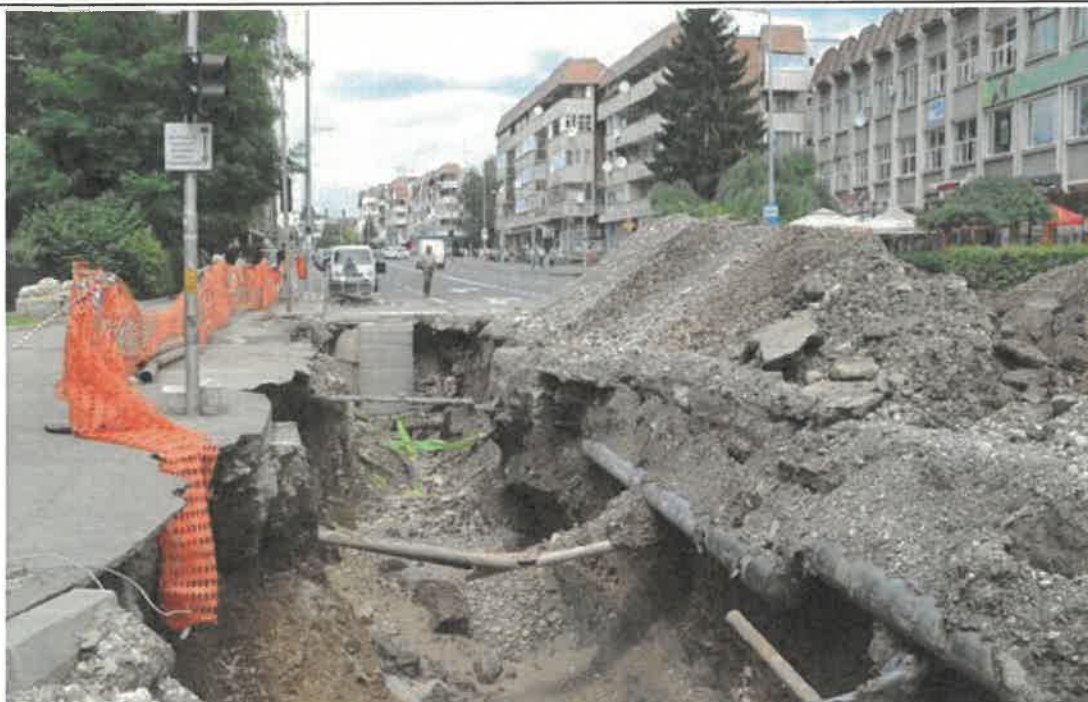
31. 2015. Săpături rețele utilități urbane nesupravegheate arheologic. O viziune actuală asupra patrimoniului arheologic al ZIR1
