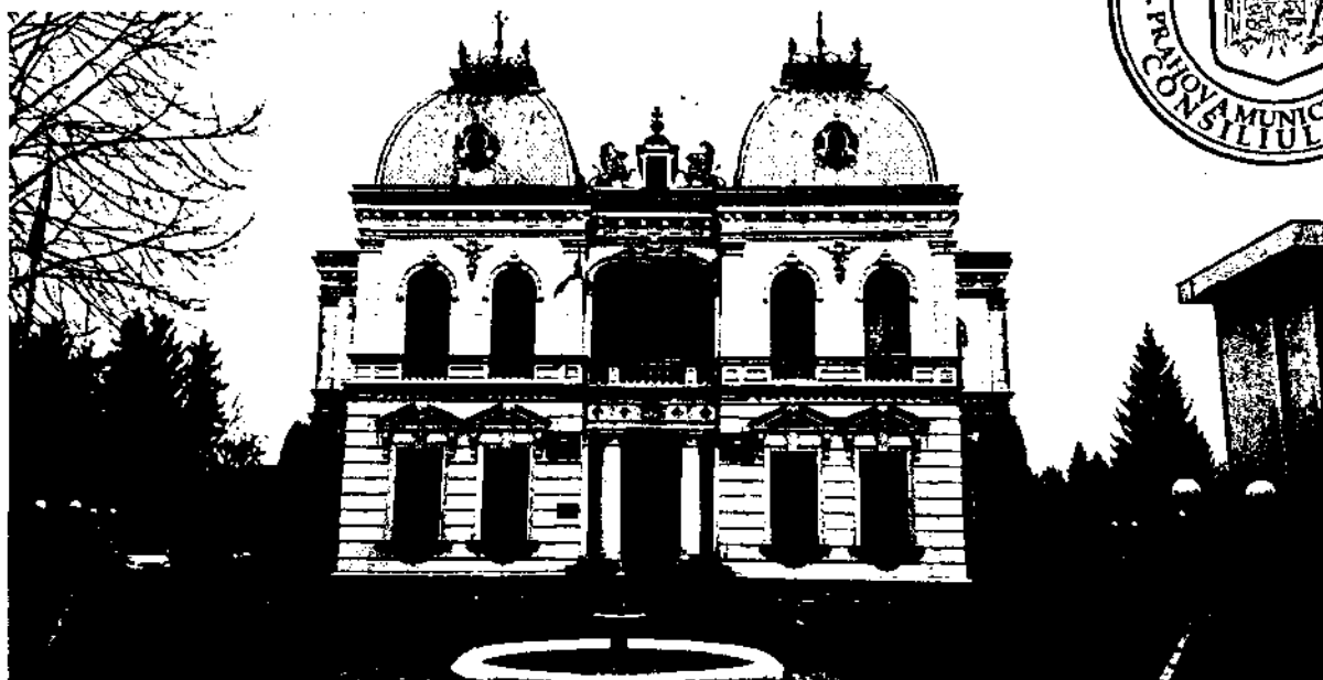
Figura 4.1 – Sediul Primăriei Câmpina
